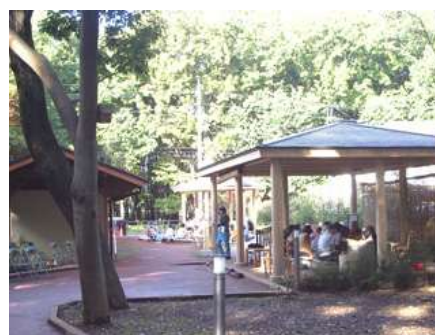
「こもれびの足湯の縁石等にもエコセメントを使用」
