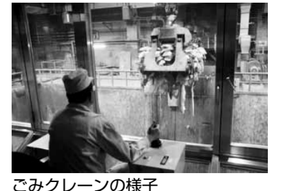
ごみクレーンの様子
