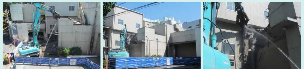
ごみ焼却施設の建設工事期間中に用地を活用するため、まずは旧粗大ごみ処理施設の解体を行っています。
