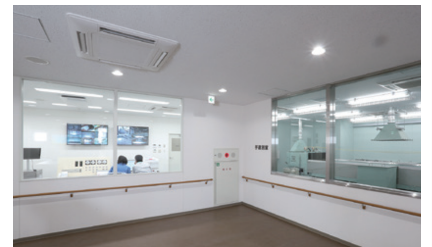
2階見学ルーム(令和2年2月撮影) 見学ルームから見た中央制御室(写真左)と、手選別室(写真右)です。見学ルートからは、このほか、プラウトホーム、ごみピットなどを見ることができます。
