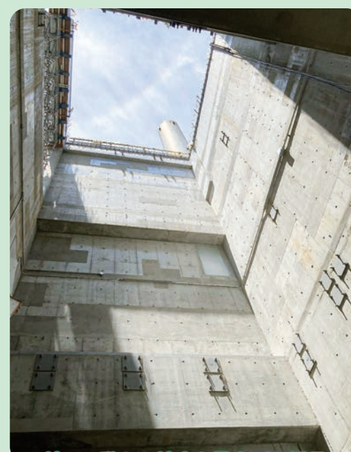
地下3階から地上を見上げた様子
