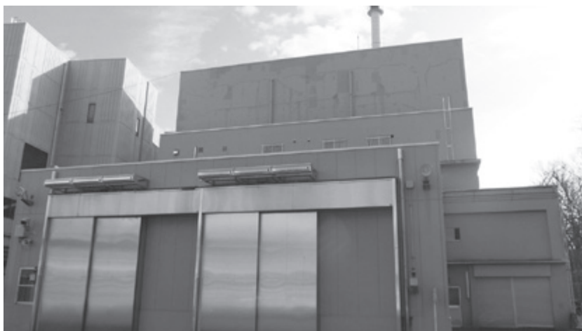
3号ごみ焼却施設
