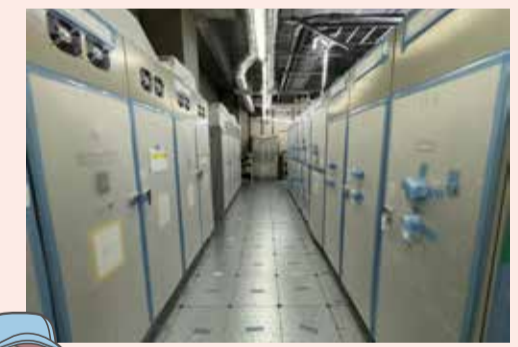
【電気室内に制御盤を設置】
