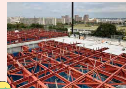
【ごみピットの屋根を施工中】
