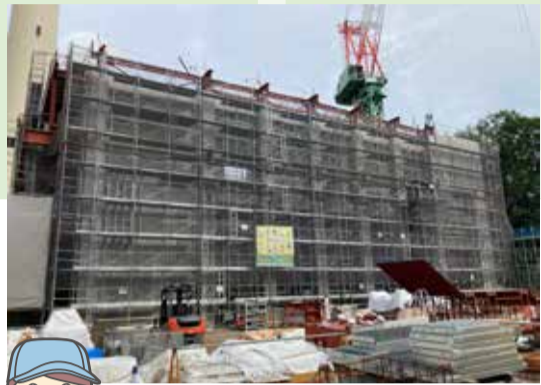
令和6年5月 建物西側の様子
