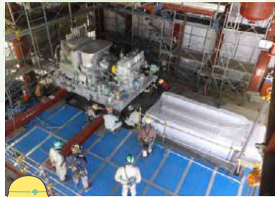
令和6年4月 蒸気タービン据付工事の様子
