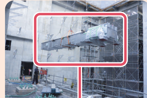
主灰コンベア(焼却炉に残った灰を運搬する設備)
