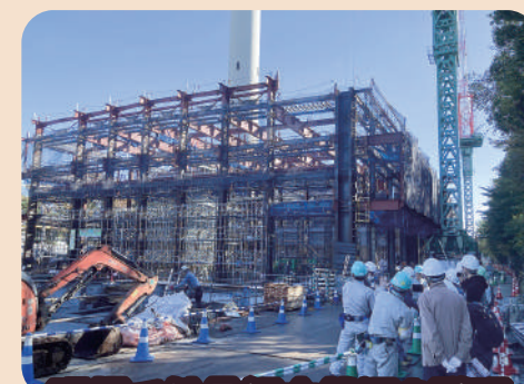
現場で鉄骨組立状況を説明
