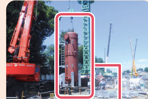
脱気器(ボイラー設備の腐食を防ぐために給水中の気体を除去する機器)
