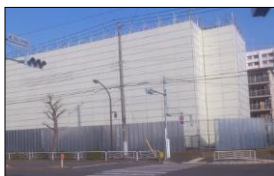
足場・防音パネル
