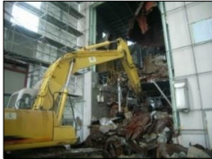
建設機械 (バックホウ)
